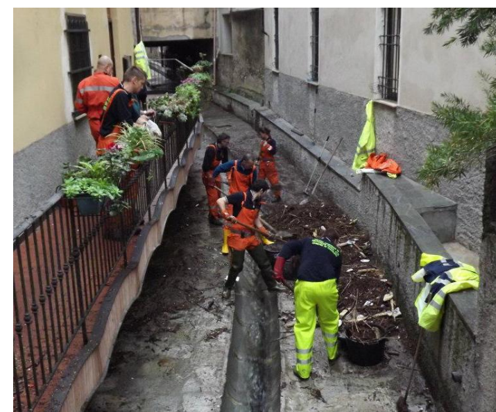
Nella foto, il Gruppo Comunale di Protezione civile ed Antincendio Boschivo, impegnato in operazioni di rimozione detriti nell'alveo di un rio durante la fase finale di un'emergenza meteo
